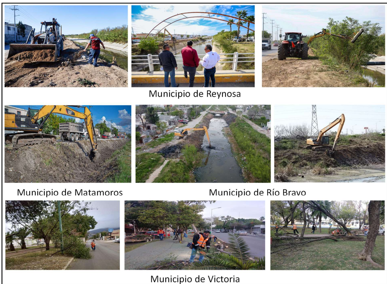
Figura 22. Actividades municipales previas a la temporada de Lluvias y Ciclones Tropicales.
