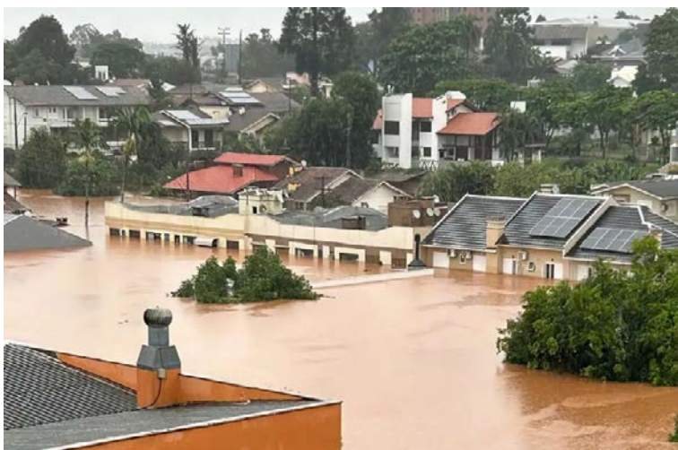
Fig. 12. Daños por inundaciones.
